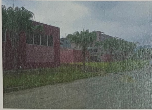
项目南面为礼志厂的废旧污水处理站及工业厂房
