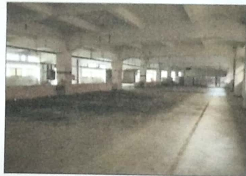
项目生产车间现状
