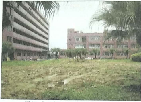
项目东面为工业厂房
