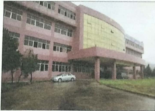
附图 4: 项目厂房外观和车间内现状
